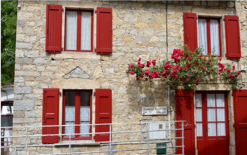
Crédit photo : 01-DSC_0084 (Valès)
