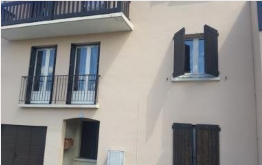
Crédit photo : Cascades Location côté sud 1 er étage (Cascades Location)
