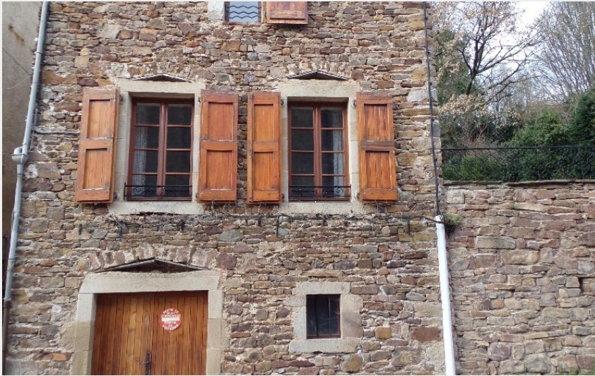
Crédit photo : COT Christophe (OFFICE DE TOURISME DU ROUGIER DE CAMARES)
