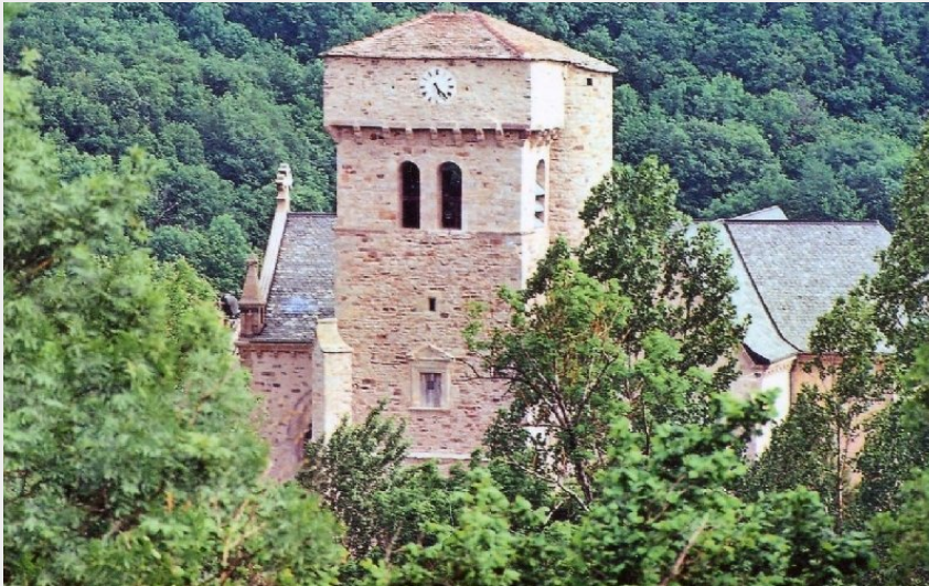
Crédit photo : Vue sur la tour (Mairie de Martrin)
