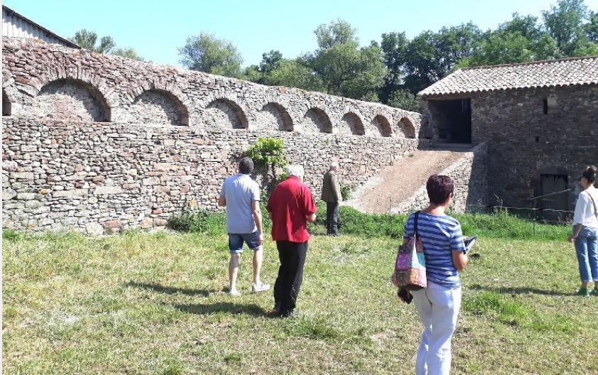
Crédit photo : Site de la Noria - Rue du Barry (OT Camarès)
