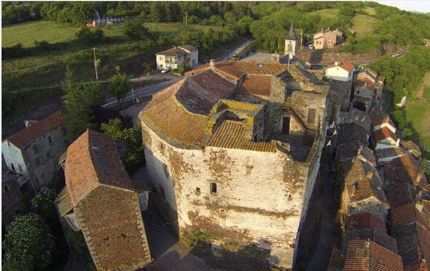
Crédit photo : Château de Latour (Château de Latour-sur-Sorgues)
