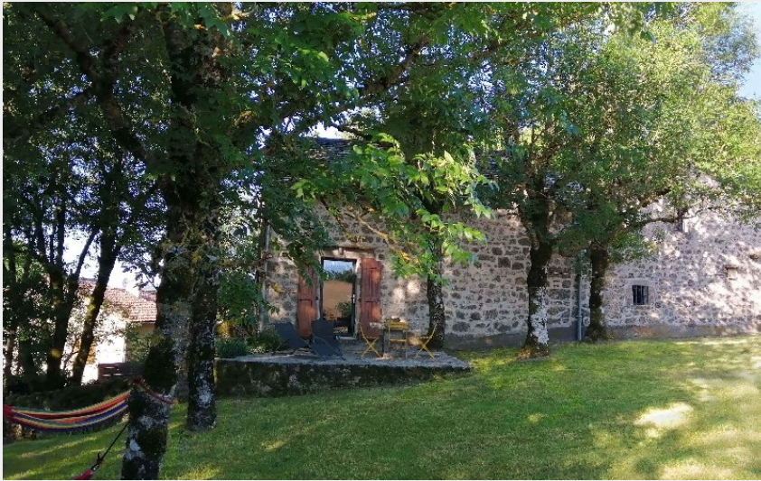
Crédit photo : La Carline (La Carline)
