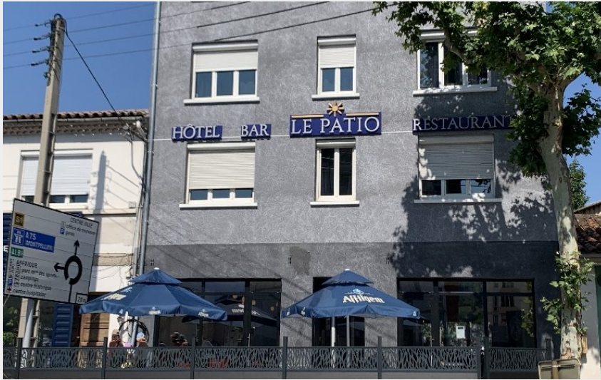
Crédit photo : Restaurant Le Patio (Hôtel Le Patio)
