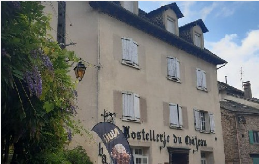
Crédit photo : Hostellerie du Château (LC OTRSA)
