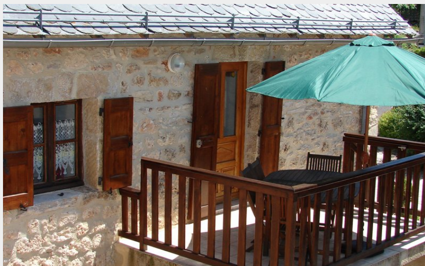
Crédit photo : 1 (TERRASSE)
