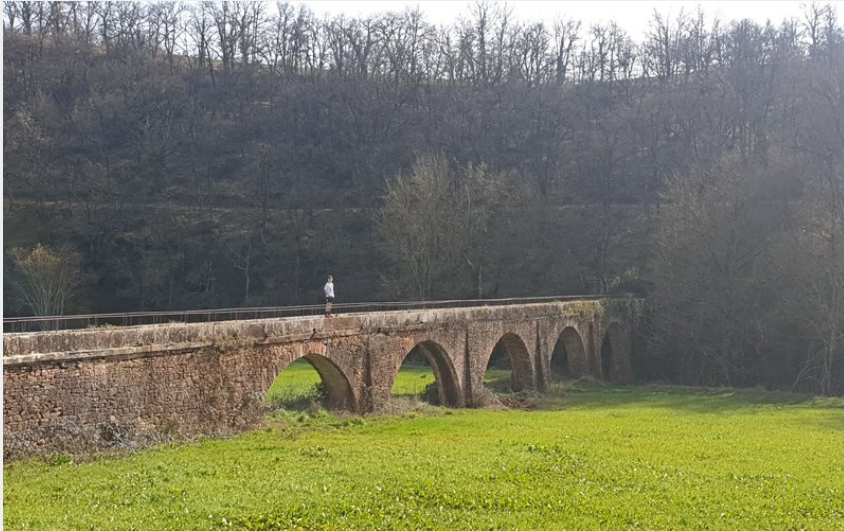
Acqueduc du Grauzou (Roquefort tourisme)
