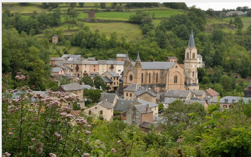
Vue de St Sever (OT RAS)
