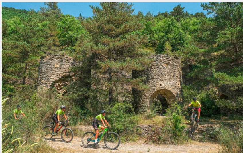
Les fours à calamines dans le ravin des Valettes (Virginie Govignon - OT Larzac et Vallées)
