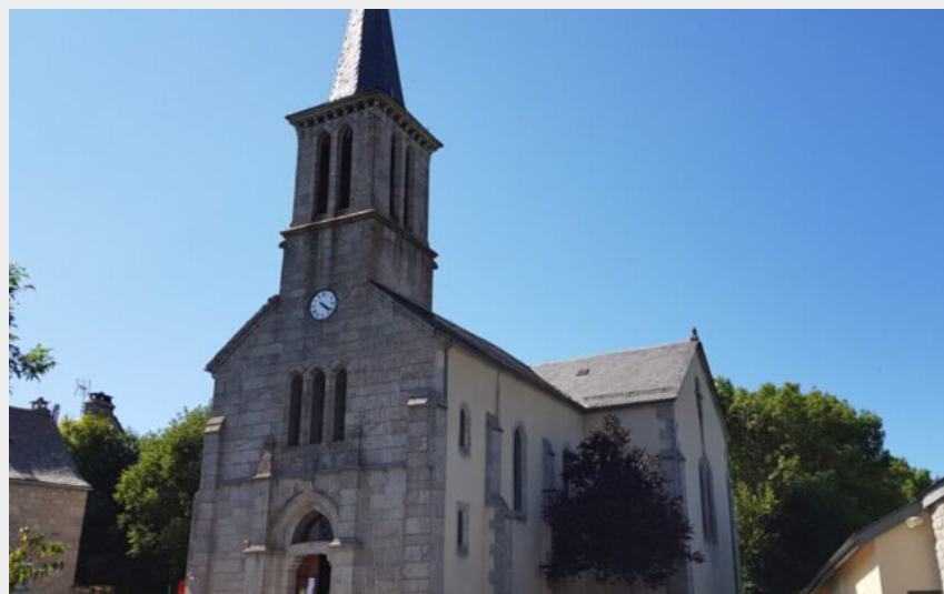
L'église de Saint-Laurent-de-Muret (OTCC Gévaudan Destination)
