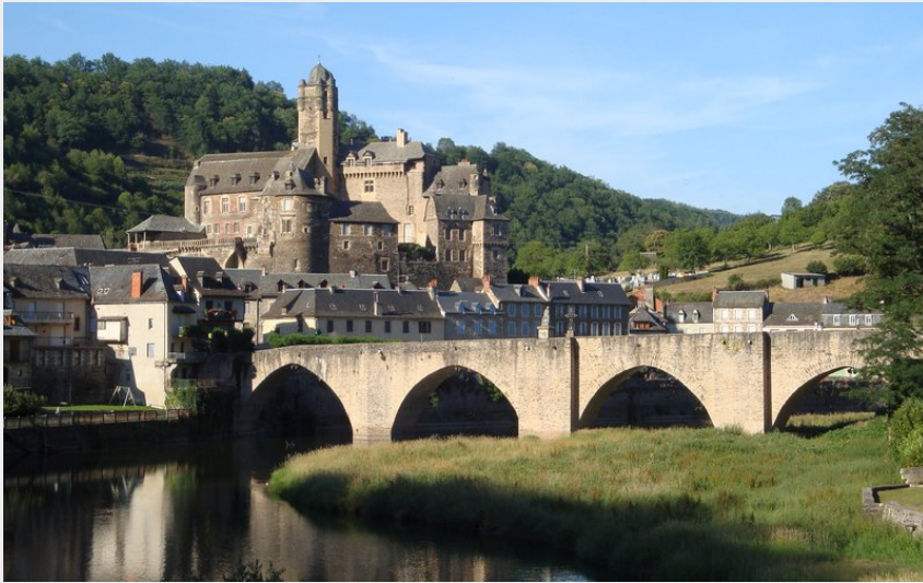
Le pont d'Etaing (OT Terres d'Aveyron)
