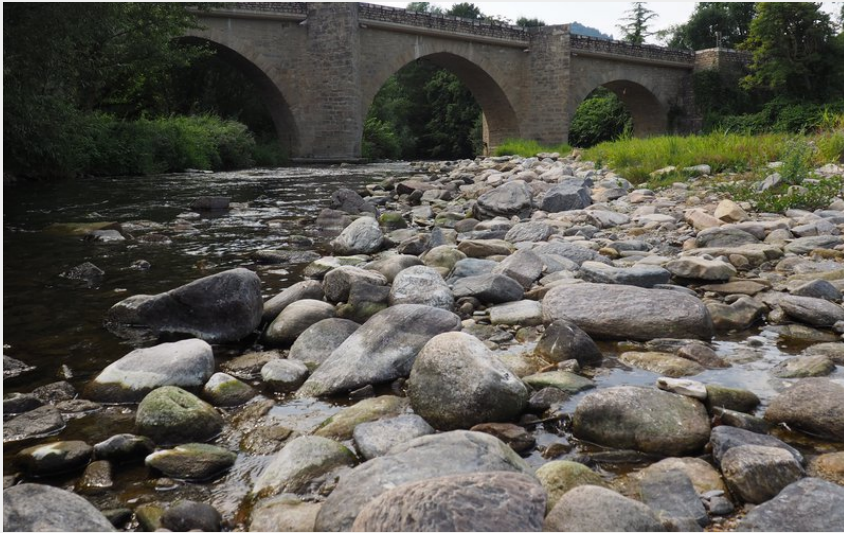
vue sur le pont de la colagne (OTCC)
