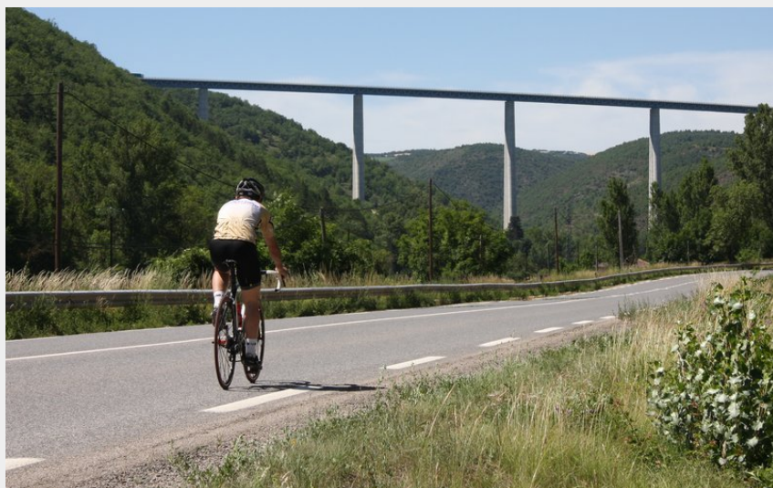
Viaduc de Verrières (@Y.Blanc)
