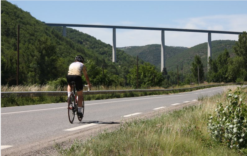
Viaduc de Verrières (@Y.Blanc)
