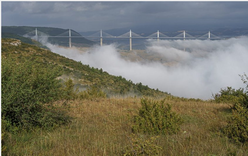
Viaduc depuis Brunas - ©Exo Dams
