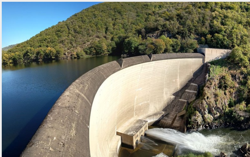
Le barrage de Couesques (3CLT©)
